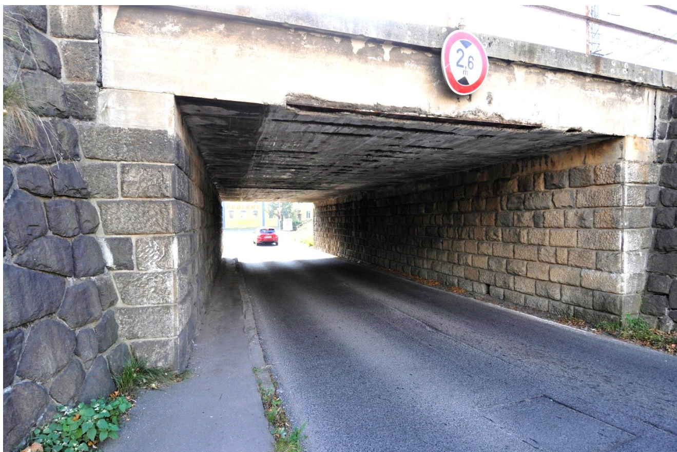
Foto 2: Most v km 190,029, který slouží zároveň i jako podchod pro zastávku K.V. – Dvory. Chodník i komunikace mají nenormovou šířku a chybí přechody. Je navržen nový most o zvětšeném rozpětí.
