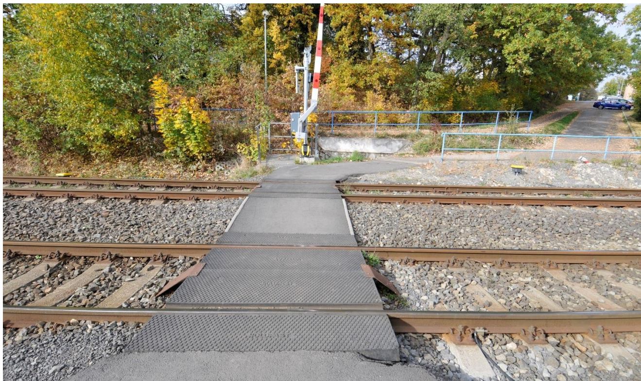
Foto 3: Přechod pro pěší č. P84 v km 188,908, stávající šířka je nedostačující.
