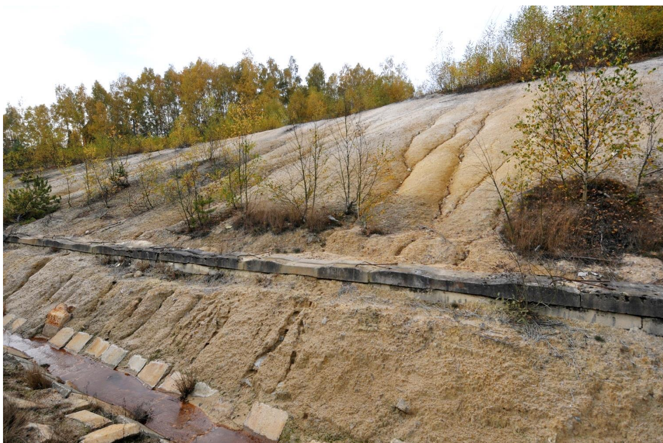
Foto 5 a 6: Zářez v mezi km 196 – 197 a erodující svahy. Jedná se o zárez v místech předešlé deponie, tvořené materiálem s výskytem siřníků, jejichž zvětvávání způsobuje vznik kyseliny sírové, která je hlavní příčinou absence vegetace, která by proti erozi v běžném případě svah ochránila.
